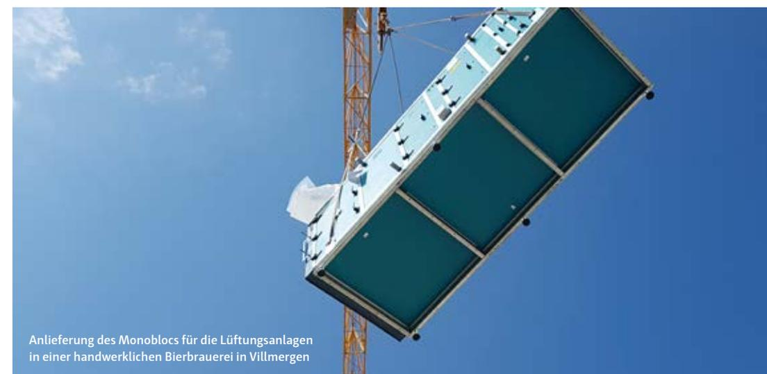
Anlieferung des Monoblocs für die Lüftungsanlagen in einer handwerklichen Bierbrauerei in Villmergen
