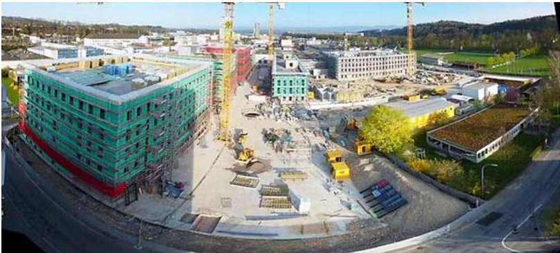
Panorama-Aufnahme der Baustelle, Stand April 2011.
